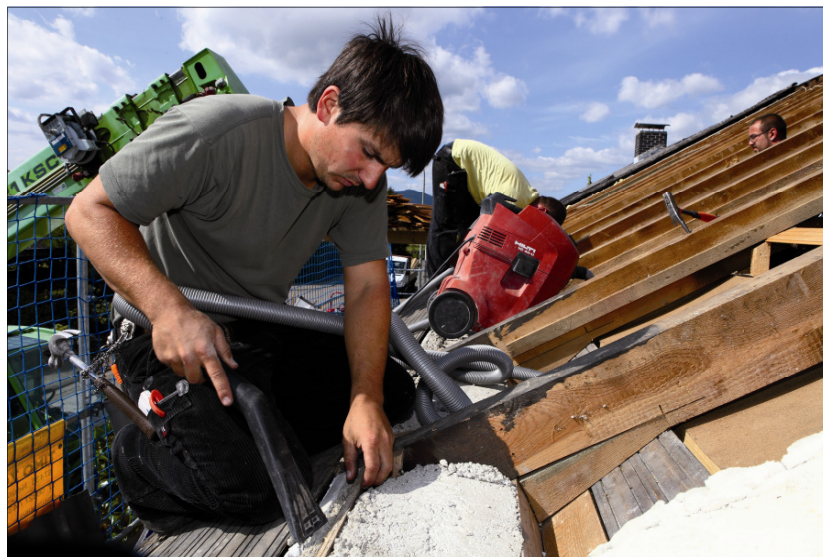
Die sorgfältige Reinigung der Anschlüsse vor der Verlegung der Dampfbremse ist wichtig.
