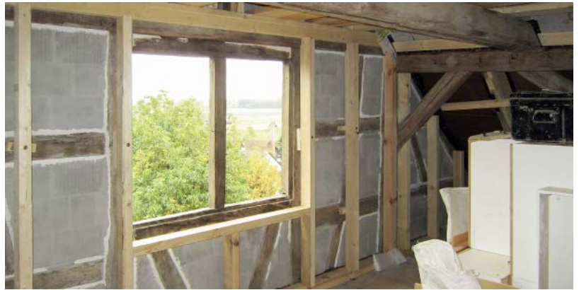
4 Bei dieser Fachwerkwand wurde vor dem Anbringen der Innendämmung der Innenputz nachgebessert, um die Winddichtigkeit bei den Ausfachungen zu gewährleisten.
