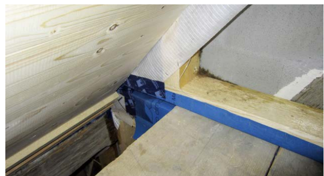
3 ... das jedoch im Bestand auf der Baustelle viel Sorgfalt, Geschick und Mitdenken von den ausführenden Handwerkern erfordert.
