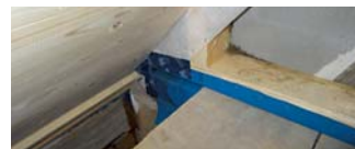
Durchgängige Luftdichtung am Deckenaufleger.
