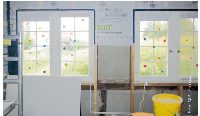
Innendämmung einer Riegelwand mit feuchtevariabler Dampfbremse.
